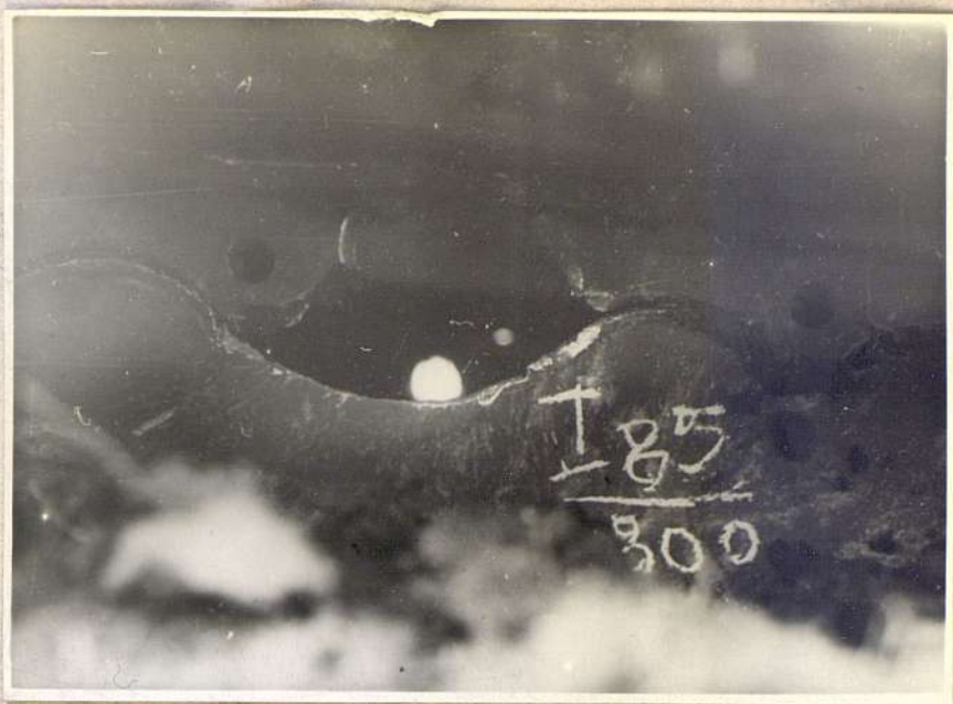
Фото № 31. Попадание бронебойного снаряда 85 мм зенитной пушки в нижний бортовой лист. Сквозная пробоина. Пролонг брони размером 350 x 230 мм. Дистанция обстрела 800 метров.
