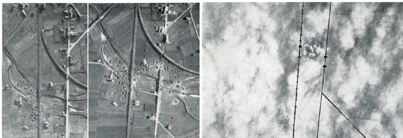
Фотоконтроль первого применения SHORAN с В-25 по мосту на окраине г.Фиденца. Слева – состояние цели до налёта, посередине – состояние цели после налёта, справа – фотоконтроль попаданий (видны взрывы сквозь облачность), дополнительно на фото нанесено положение жд линии (слева от разрывов бомб) и автомобильной дороги (справа от разрывов) с мостами.
