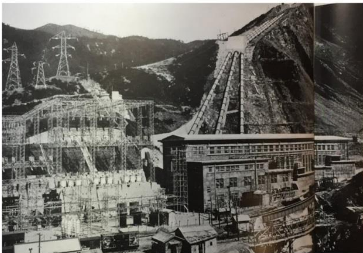
長津江第一發電所建屋及び据付中の鉄管を望む
