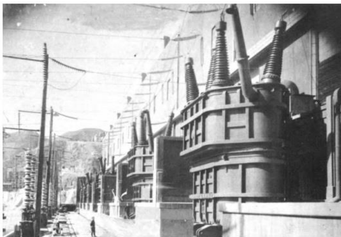
Слева - ГЭС Сунхун (японское название - Suihō). Построена Японией в 1944 г., на момент ввода в эксплуатацию – 3-я в мире по мощности. Бетонная плотина имела высоту 105 м и длину 885 м. Трехэтажное машинное здание шириной 20 м и длиной 180 м расположено на корейском берегу у основания плотины. Справа - на японском фото 1944 г. показаны трансформаторы мощностью 100000 кВА каждый.
