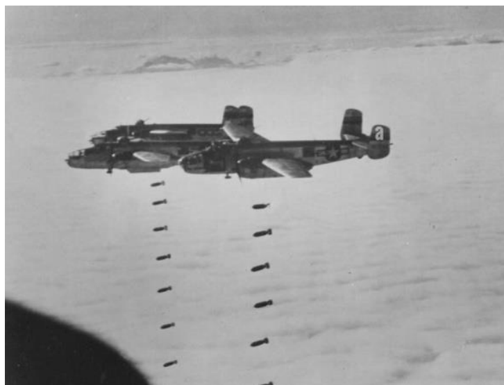
Сброс бомб с В-25, оборудованных аппаратурой SHORAN, в условиях сплошной облачности по цели в Болонье 15 декабря 1944 г.
